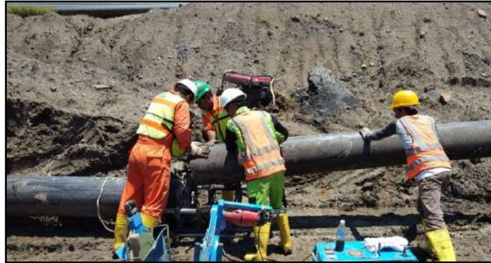
Gambar 4.7 Penyambungan Pipa HDPE
